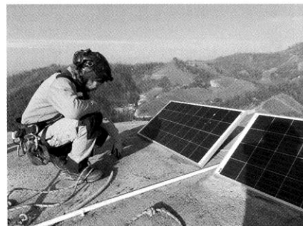
Controllo della impermeabilizzazione. Foto ditta Dar.Do.
