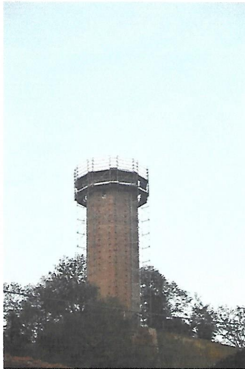
La Torre panoramica di Corneliano con i ponteggi
